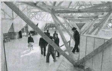
三角形に組み合わせた道産木材の柱が並ぶ「森のようちえん」開舎＝3月23日
